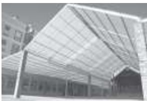
Cobertura translúcida do largo
